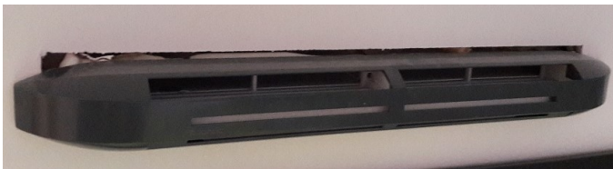
Mauvais positionnement du module d'entrée d'air sur l'ouverture de la fenêtre → défaut d'étanchéité à l'air
